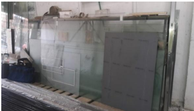
Figura 7. Inadecuada disposición de los materiales delicados
