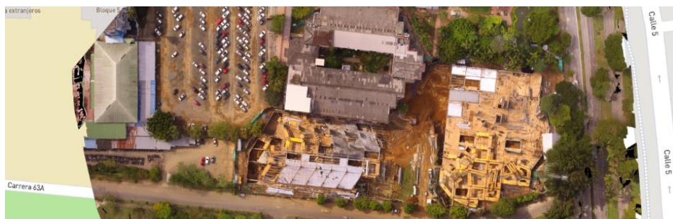
Figura 4. Localización general de la construcción civil. Fuente: José Eduardo Fuentes Delgado-Javier Ferney Castillo.
