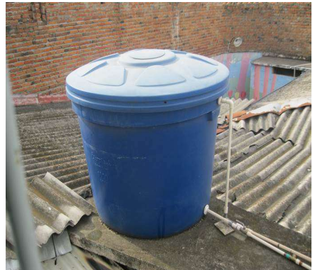
Tanque de almacenamiento de agua potable
