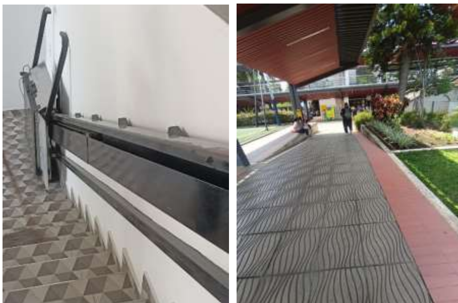
Ilustración 2. Elevadores de escalera Bloque 1 y zona de acceso al Boulevard
