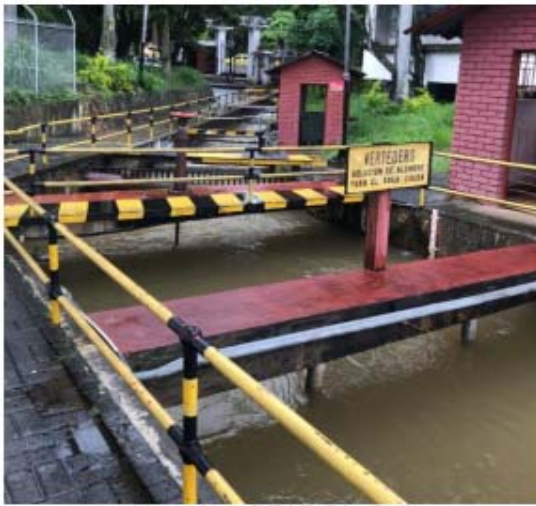
Vertedero PTAP Río Cali
