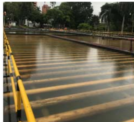
Sedimentadores de alta tasa
