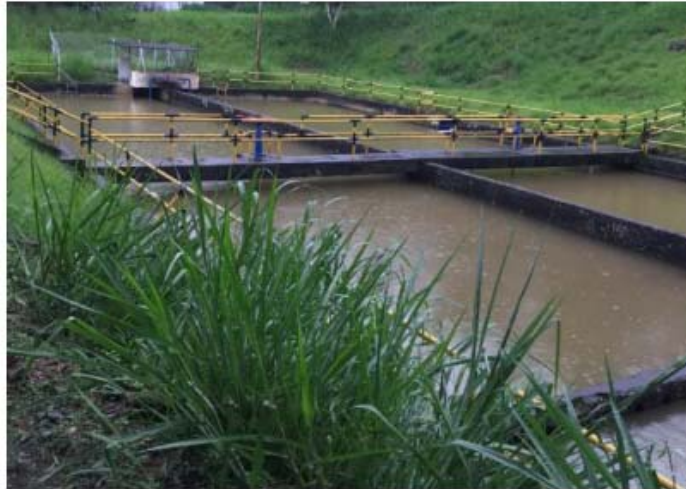
Sistema de desarenación Sistema Río Cali
