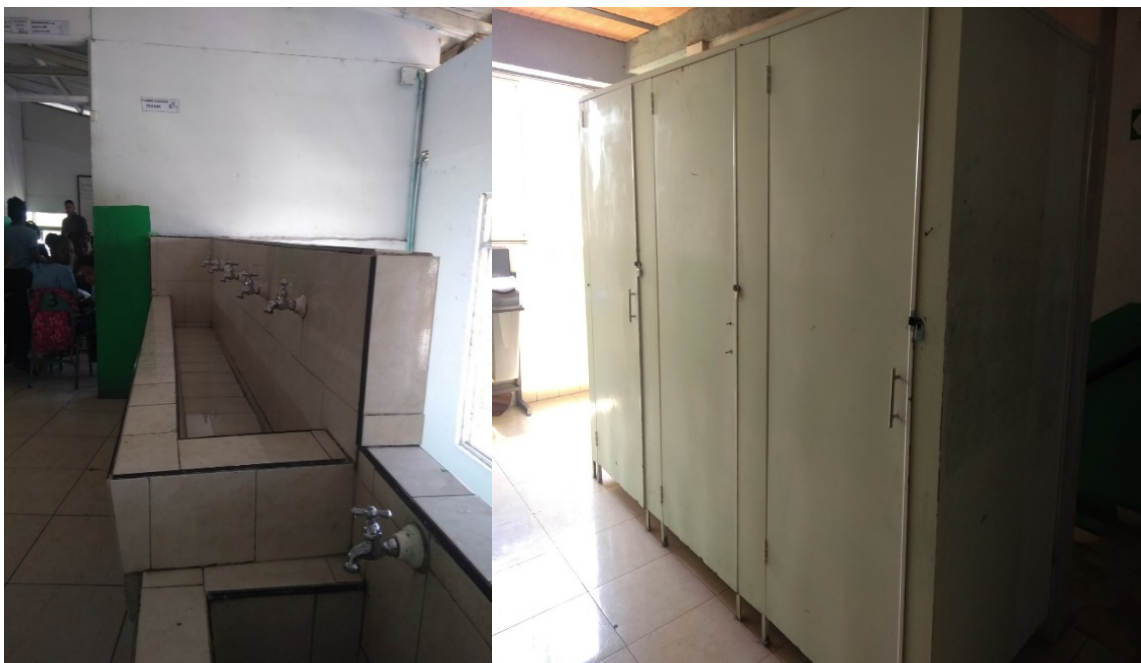
Gráfico 8. Torre a ejemplo de bebederos de agua y unidades de sanitarios. Adaptación propia Fundación escolar Nelson Mandela.
